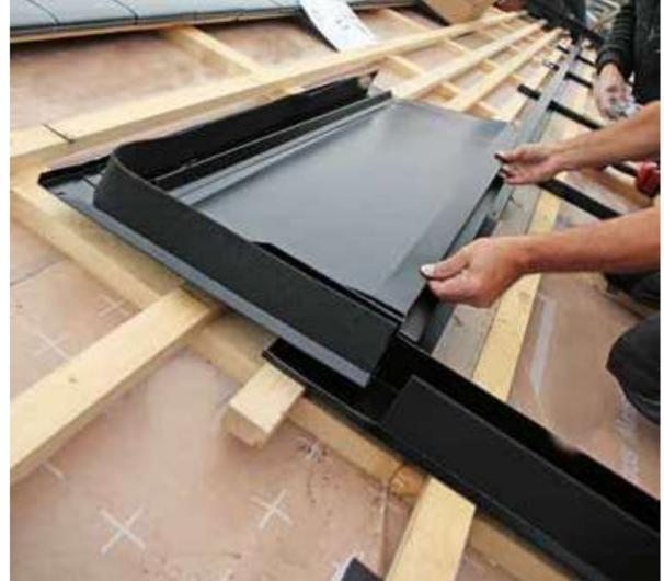
in die Dachdeckung aus. Die Module werden anstelle der Dachpfannen eingesetzt und ermöglichen so ein gestaltetes und harmonisches Deckbild. Besonders vorteilhaft ist die besonders schnelle und wirtschaftliche Verlegung der Module. Die Module der dachintegrierten Systeme sind hinterlüftet – einmal in der Konterlattenebene und zum anderen durch spezielle Lüftungsschlitze in den Modulen. So werden mögliche Leistungsverluste durch stärkere Erwärmung der Elemente verhindert.
